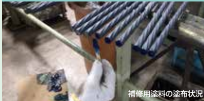
補修用塗料の塗布状況
