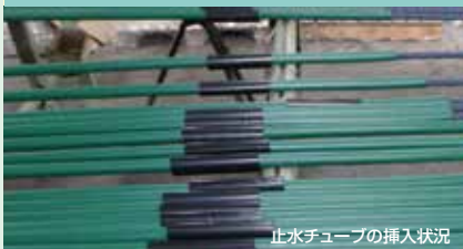
止水チューブの挿入状況
