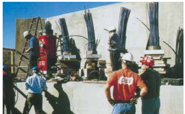
海外でのダム工事現場
