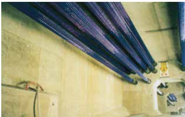
橋梁の桁内に外ケーブルとして配置されたECFストランド
