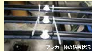
アンカー体の結束状況
