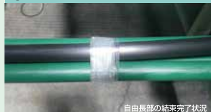
自由長部の結束完了状況
